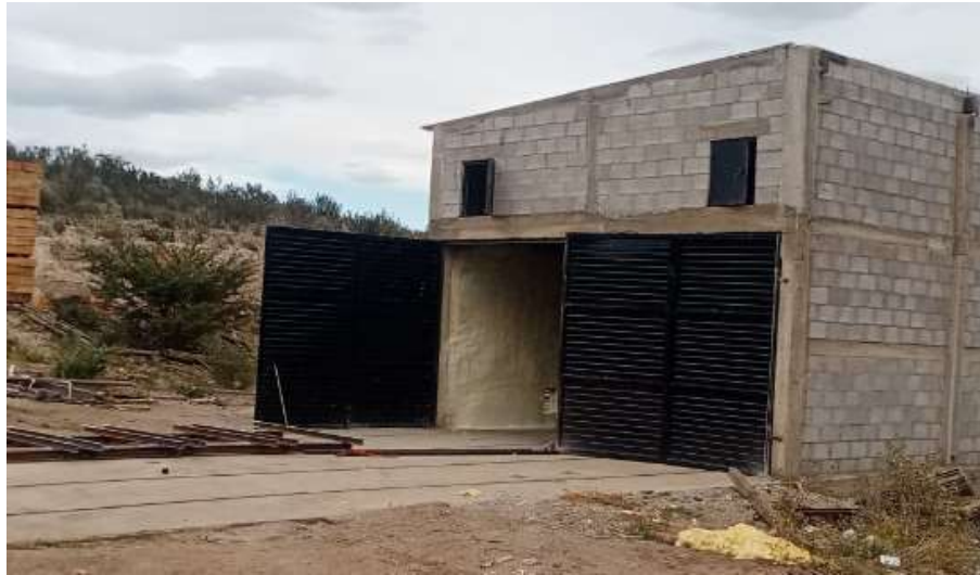
Cámara para el tratamiento térmico de las tarimas
